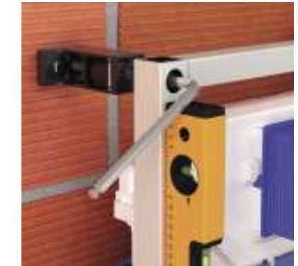
2 Прикрепите инсталляцию к полу и стене и отрегулируйте настенные крепежные скобы EasyFix™, убедившись, что инсталляция выровнена по уровню со стеной.
